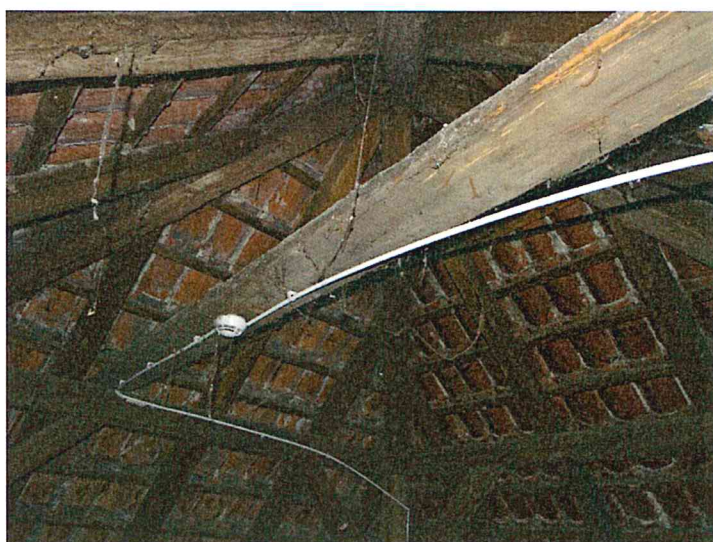
Fot.5 Widok więźby nad wejściem do budynku- dach czterospadowy
