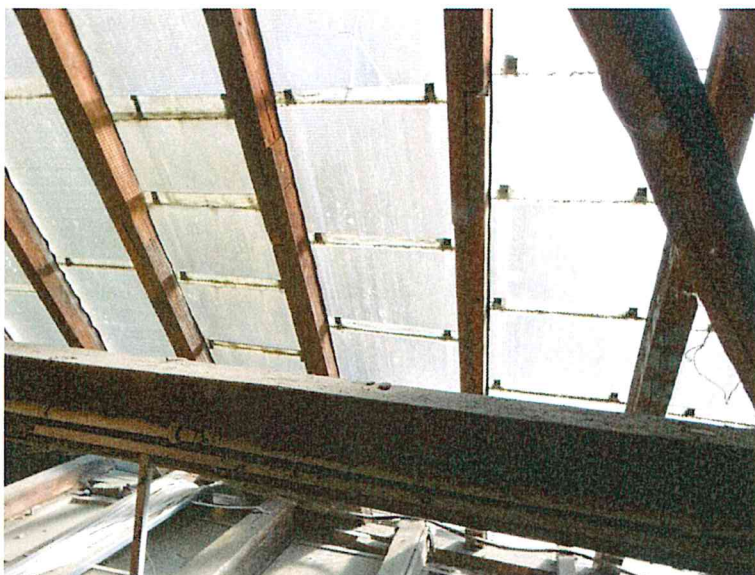
Fot. 6 Fragment "wieży" północnej- widoczne łączenia krokwi na nakładkę
