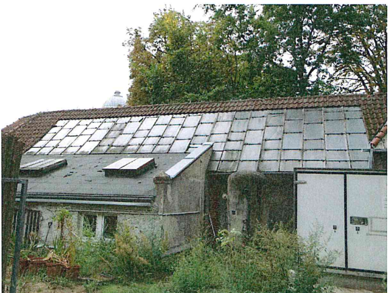
Fot. 3 Część zachodnia- widoczna jedna z przybudówek i fragment dachu kryty szkłem zbrojonym
