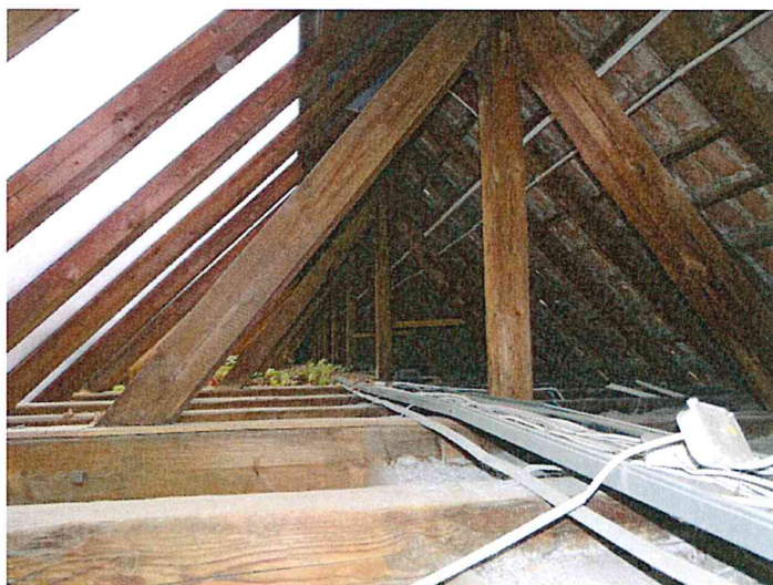
Fot.4 Widok ogólny dwuspadowej więźby dachowej
