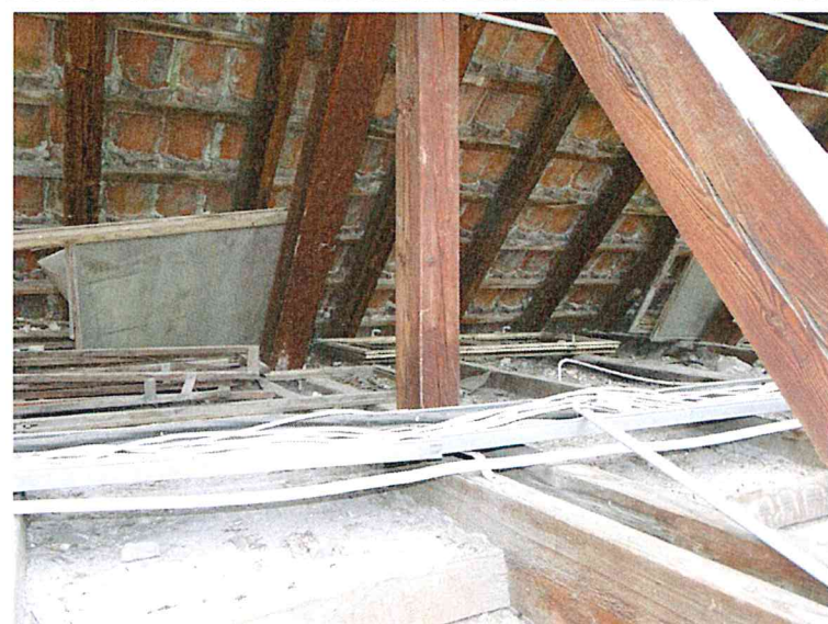
Fot. 7 Fragment poddasza- widoczny ślepy pułap
