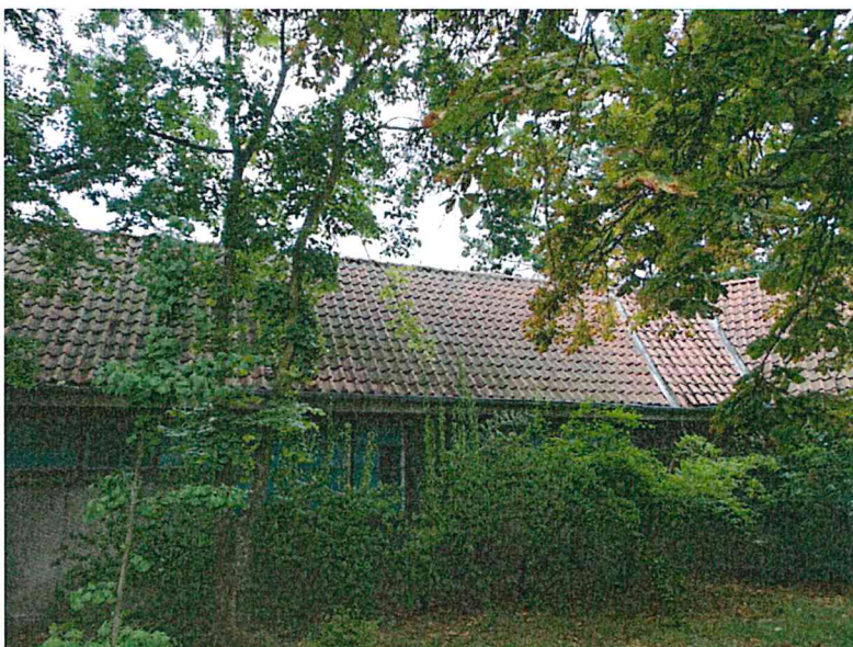
Fot.2 Część wystawiennicza budynku z dachem dwuspadowym
