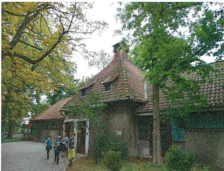
Fot.1 Wyjście z budynku pokryte czterospadowym dachem
