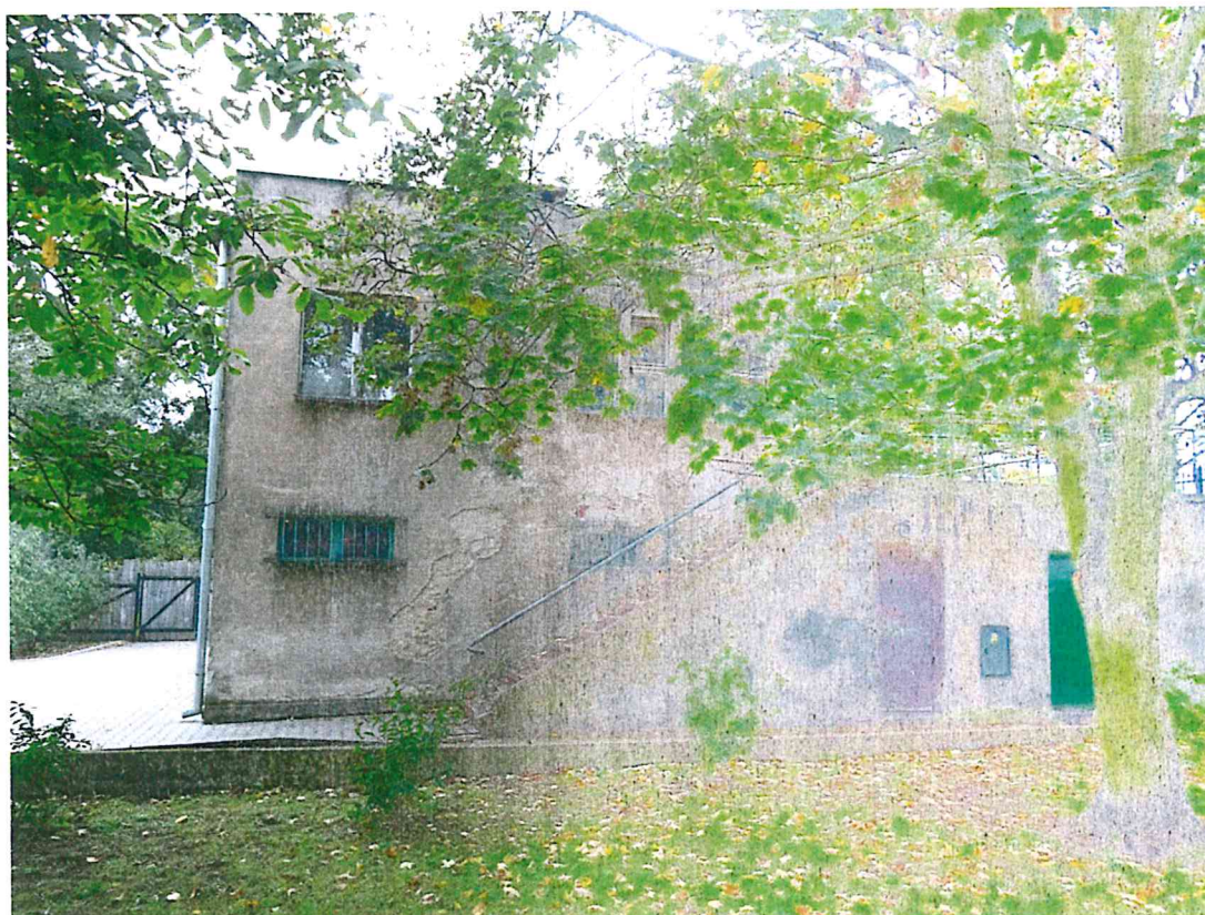
fot.4 Widok od strony zachodniej
