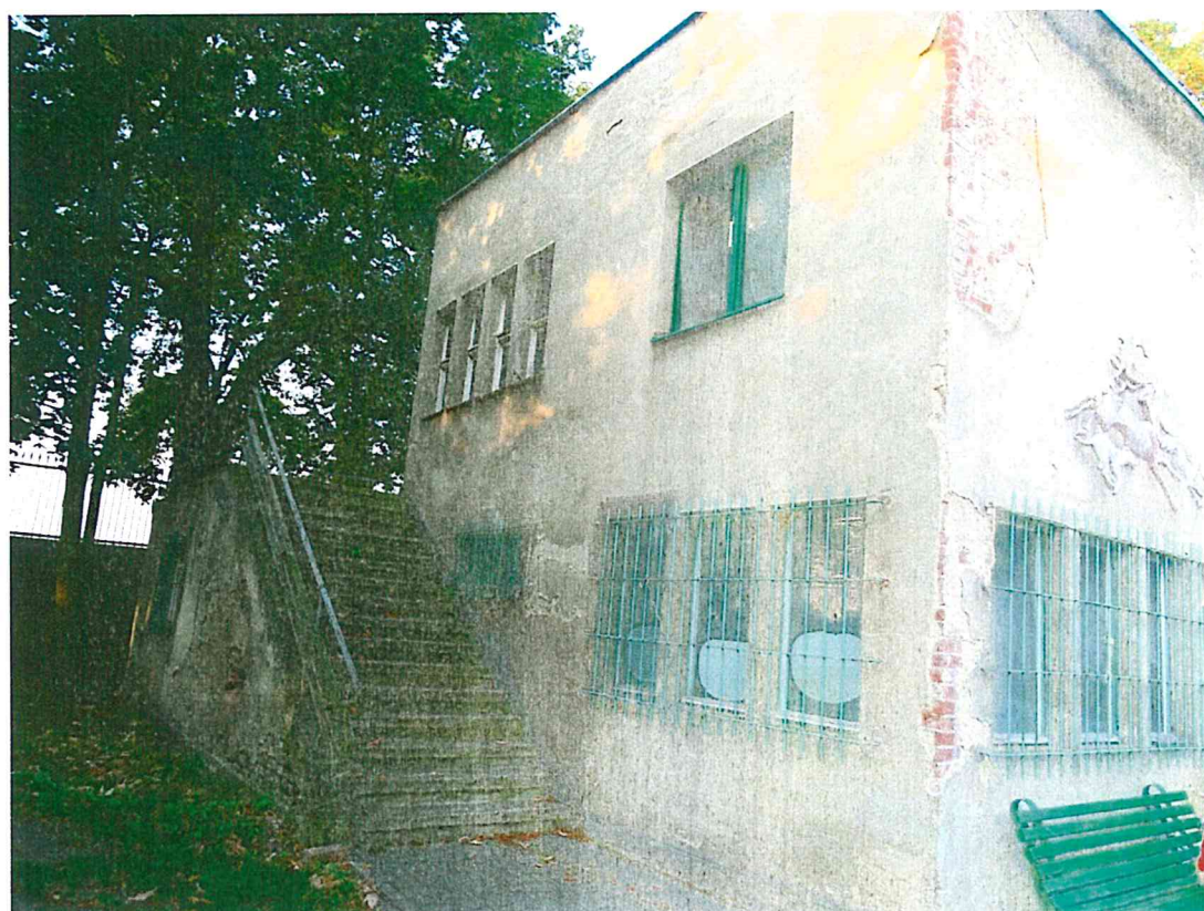
fot.2 Widok od strony wschodniej
