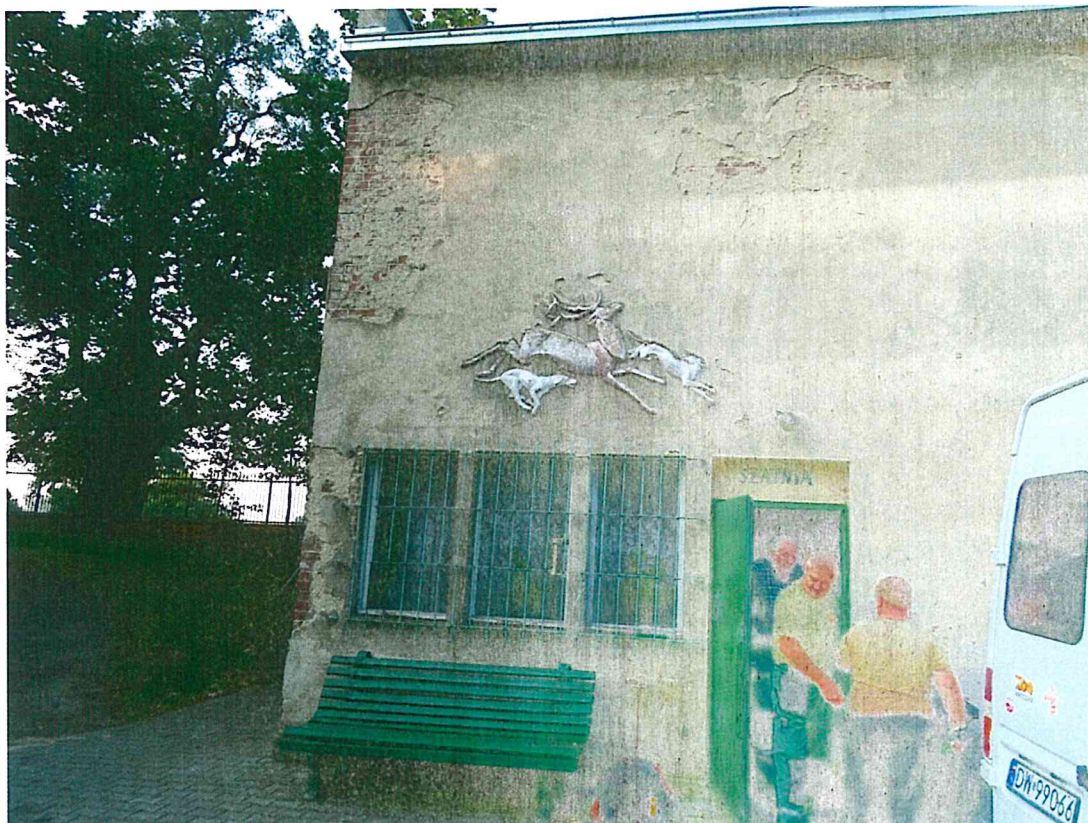
fot.1 Fragment elewacji północnej
